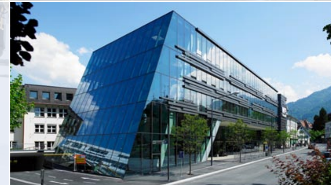
Das spezielle System-Glas von MGT minimiert im Winter den Wärmeverlust nach außen hin. Gleichzeitig verhindert es die übermäßige Erwärmung durch direkte Sonneneinstrahlung im Sommer.
