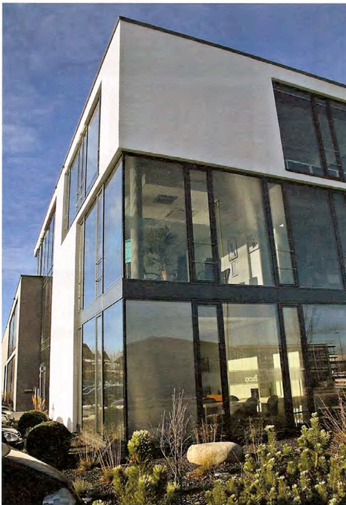
Sicht- und Sonnenschutz für die Büroräume mit in den Scheibenzwischenraum integrierten Jalousien.
